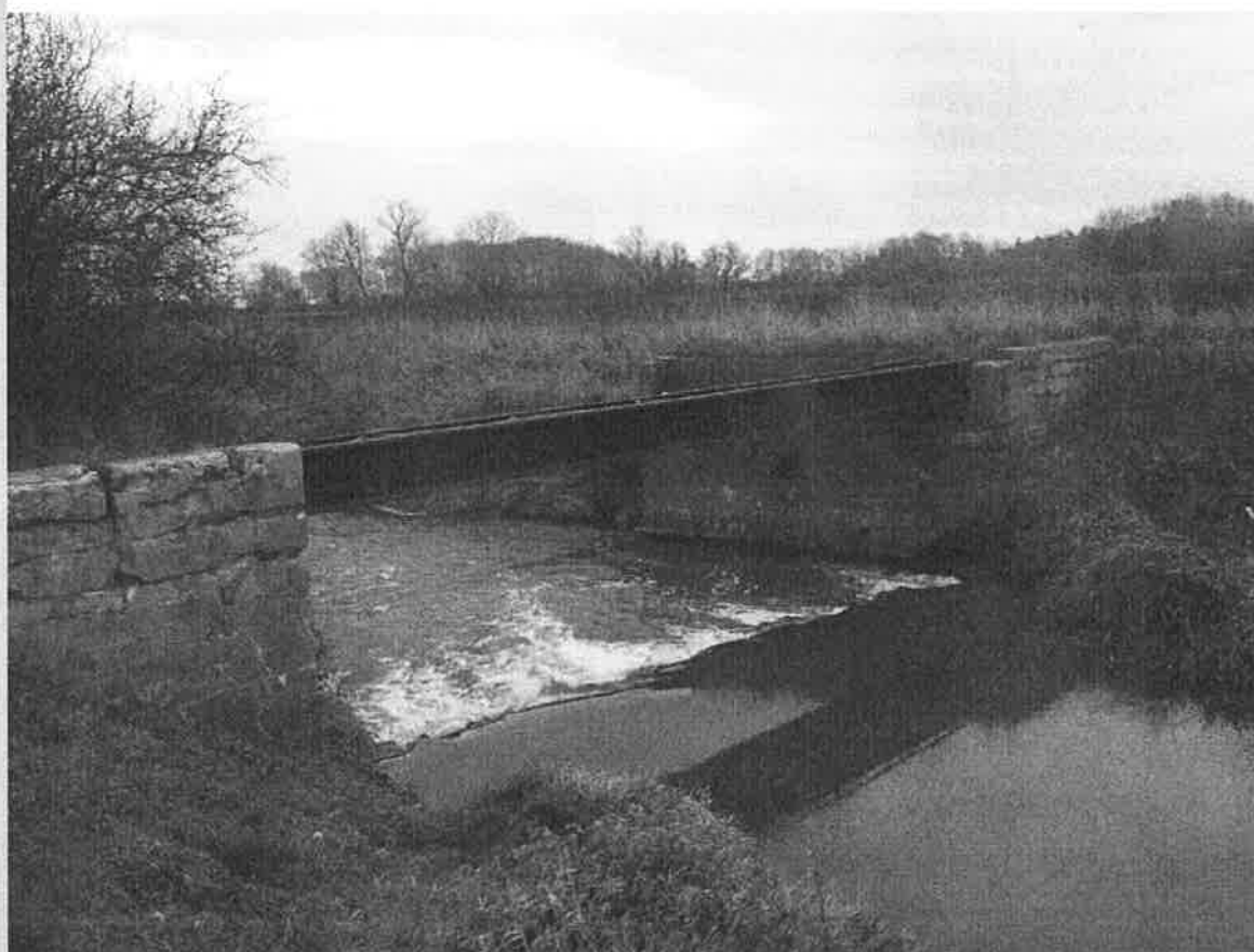
10. Galowice. Pozostałości mostu nad Ślężą na trasie dawnej kolejki dostawczej Galowice - cukrownia Żórawina. (PA)
